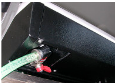
odvod chladící kapaliny
